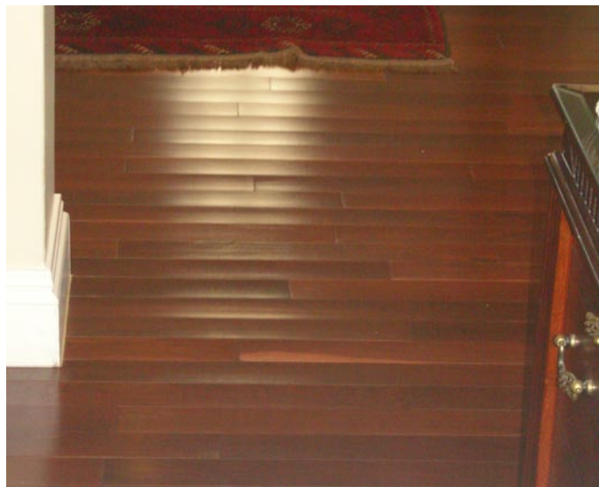
Der rötliche Holzboden ist verklebt und hat sich ausgedehnt und aufgeschüsselt. Hätte man ihn auf Elastilon verlegt, wäre das nicht passiert!
