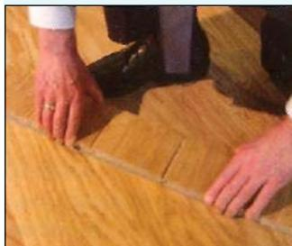
Die Unterlagsmatte ist flexibel und dehnbar, so dass laut Osbe die Scherkräfte des Holzes beim Quellen und Schwinden aufgenommen werden können.
