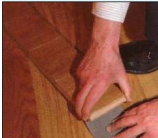
Die neue, zweiseitig klebende Unterlagsmatte Elastilon Removable lässt sich wie ein Haft-Notizzettel bei Bedarf rückstandsfrei wieder aufnehmen.
