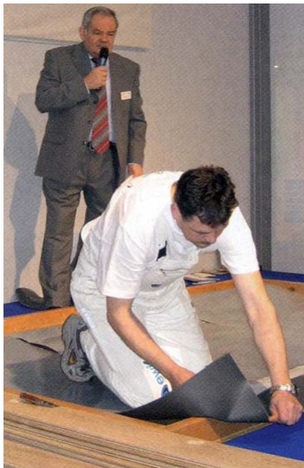
Live-Verlegung in der Domotex-Werkstatt - das nächste Mal ist Elastilon auf der Europarket in Maastricht zu sehen.
