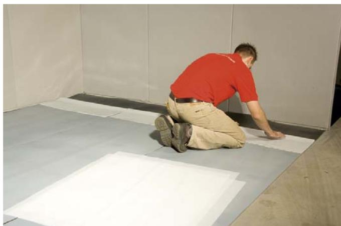
Rimuovere il foglio di protezione ad esempio fino alla larghezza di una o due sezioni di strato adesivo. Ora lo strato adesivo risulta visibile.
