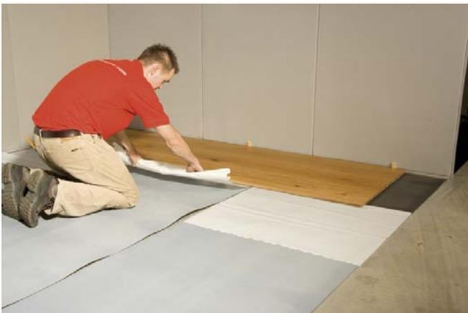
Inserire la seconda sezione di palchetto nella prima fino a eliminare le giunture, quindi eliminare il foglio ausiliario fra Elastilon e le sezioni di palchetto. Ora si procede con lo strato di protezione di Elastilon.
