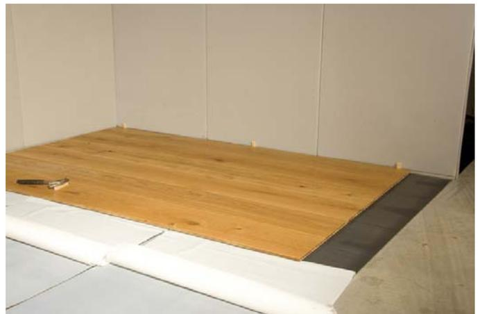
D'ora in avanti è possibile posare più sezioni senza creare giunture prima di rimuovere lo strato di protezione fra il legno e Elastilon.
