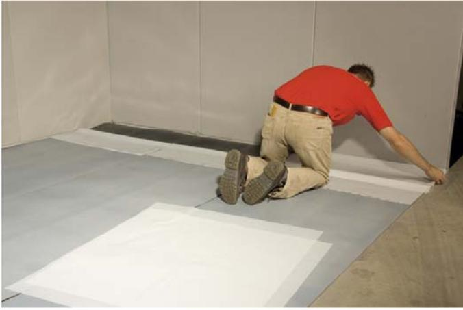
Coloque con cuidado el film auxiliar sobre la cara adhesiva ahora expuesta, con el pliegue en dirección a la pared.
