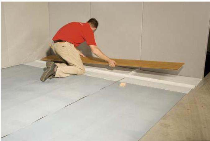
La primera parte de la lama del pavimento estará ahora colocada sobre el film auxiliar.
