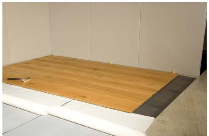
A partir de aquí, se podrán colocar varias lamas ajustadamente antes de que la lámina protectora entre la madera y el Elastilon se retire.
