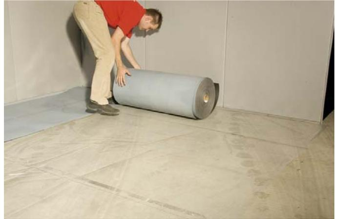
Coloque el Elastilon sobre la galga de plástico en tiras, colocándolas una al lado de la otra sin que se superpongan entre si.
