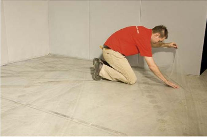
Coloque sobre el suelo a recubrir la galga de plástico, solapando tiras de 20 a 25 cms.
