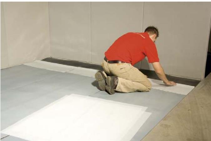
Retire la lámina protectora de la cara adhesiva hasta un ancho equivalente a la de dos lamias del pavimento a colocar. La cara adhesiva estará ahora expuesta.
